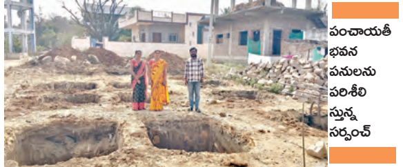
పంచాయతీ భవన పనులను పరిశీలి స్తున్న సర్పంచ్
